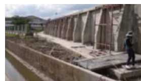
建設中の防水堤(2012年7月現在)
