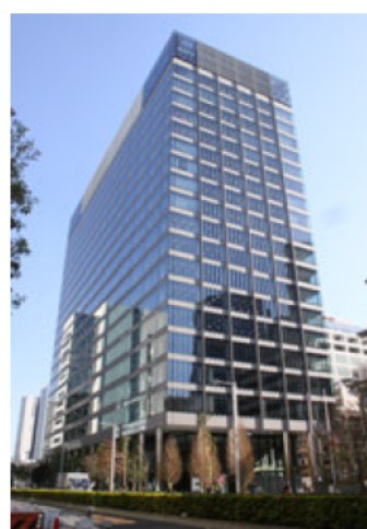
東京営業所および 朝日インテックJセールス本社の 新オフィスビル
